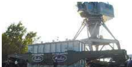
Сербия: трансформатор 400kV 400MVA
